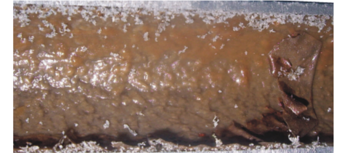
Ablagerungen können durch konsequente Hygienemaßnahmen in Wasserleitungssystemen verhindert werden.
