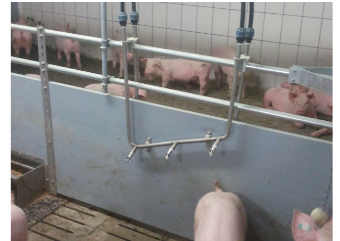
Bei Neu- und Umbauten sollten Zirkulationsleitungen oder eigene Arzneimittelleitungen ohne Sackgassen, die gesondert gespült werden können, zum Einsatz kommen
